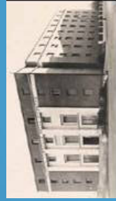
CNR - Sede Centrale
